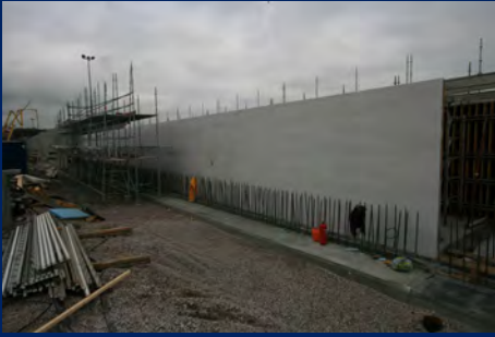
ÄMMÄSSUON KAATOPAIKAN JV-TUNNELI, ESPOO
